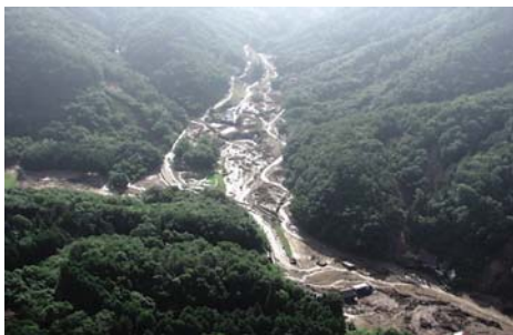
土砂崩れの状況(広島県庄原市) (写真提供: 備北地区消防組合)
